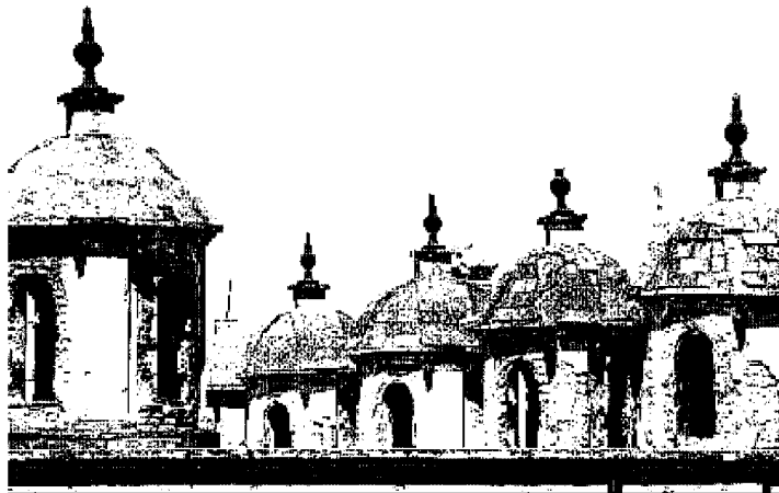
Las linternas diseñada por Jean Maritz están cada vez más deterioradas.
