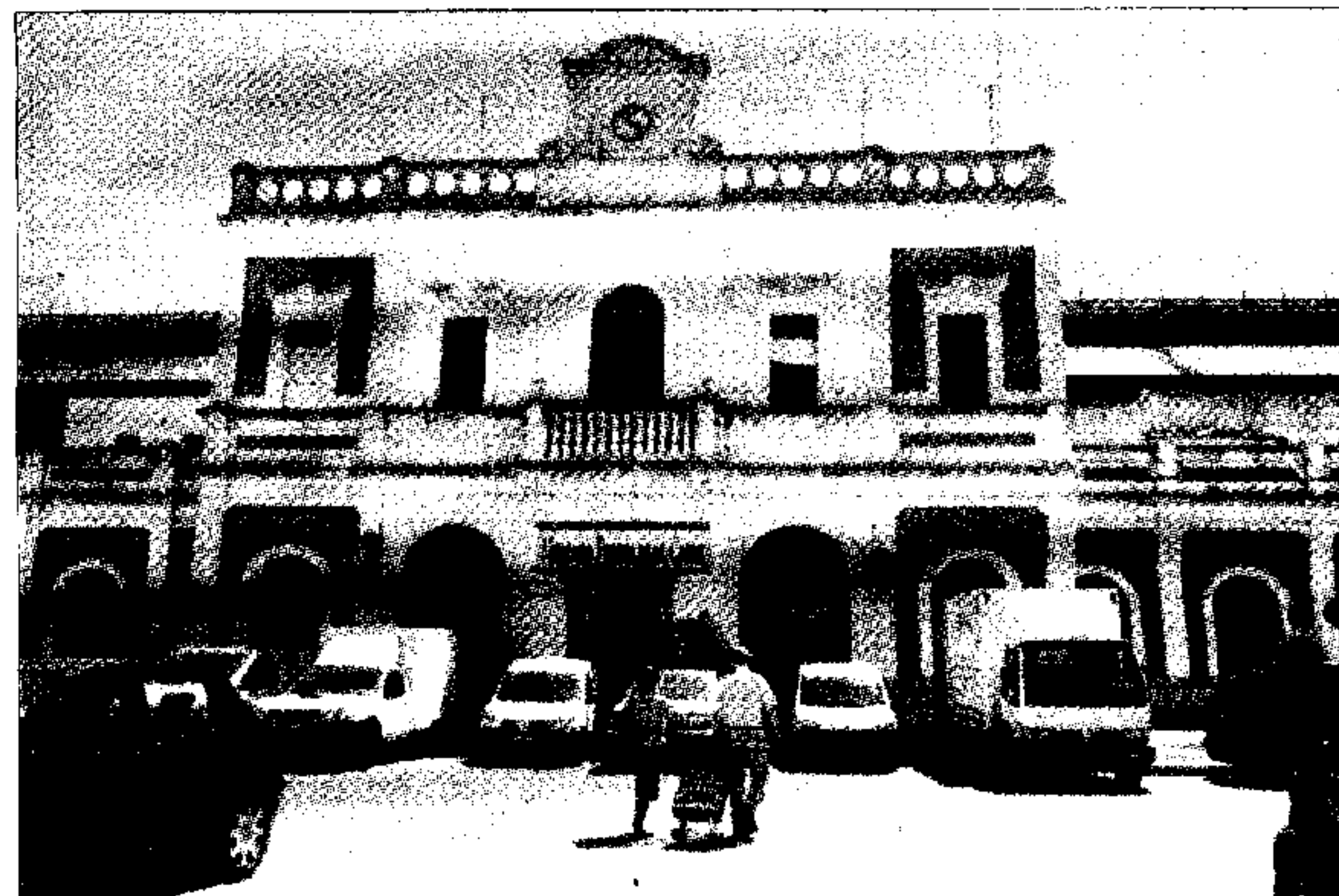
OBRAS. Explanada delantera de la estación, donde irá el parking.
