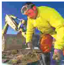
Rehabilitación de una escombrera (Reino Unido)
