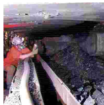
Interior de una Mina (Reino Unido)
