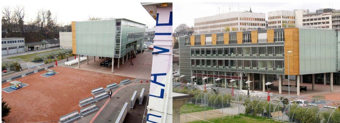
Figure 3 : A gauche, la place centrale du quartier du Flon, l'Esplanade du Flon. A droite, Les « Colonnades », qui se dresse à l'extrémité ouest de l'Esplanade du Flon. Construit entre juin 2002 et juin 2003, il accueille au rez un restaurant, aux 2 étages supérieurs des bureaux et au 3ème étage 8 lofts avec terrasse sur le toit. (Source : www.lo-holding.ch )
