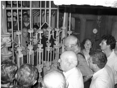
Torre de alcoholes en la Azucarera del Guadalfeo en Salobreña
