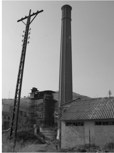
Torre de cal en la Azucarera El Pilar de Motril
