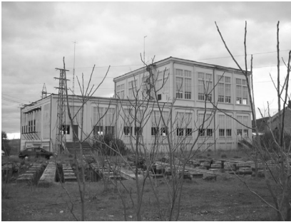
Central Eléctrica de Sevillana en Cerco Industrial de Peñarroya-Pueblonuevo
