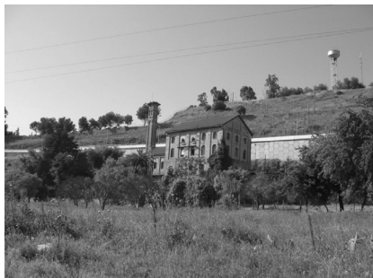
Vista general de la estación de bombeo de agua de Adufe (1873)
