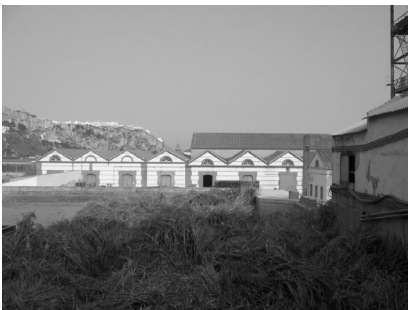
Naves de almacén en la Azucarera del Guadalfeo en Salobreña
