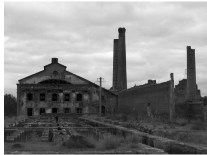
Antigua Central Térmica en Cerco Industrial de Peñarroya-Pueblonuevo
