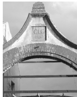
Fundición La Cruz (1830) Linares, rehabilitada por la Escuela Taller “Industria y Paisaje”
