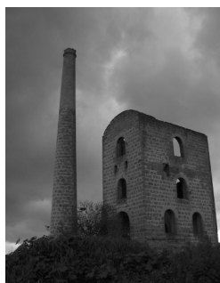
Mina Los Lores, primer proyecto de intervención del Programa de rehabilitación de Arquitectura Industrial de la Consejería de Obras Públicas
