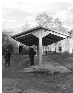
Aparcamientos de Fundición La Cruz, interesante tipología en hormigón armado
