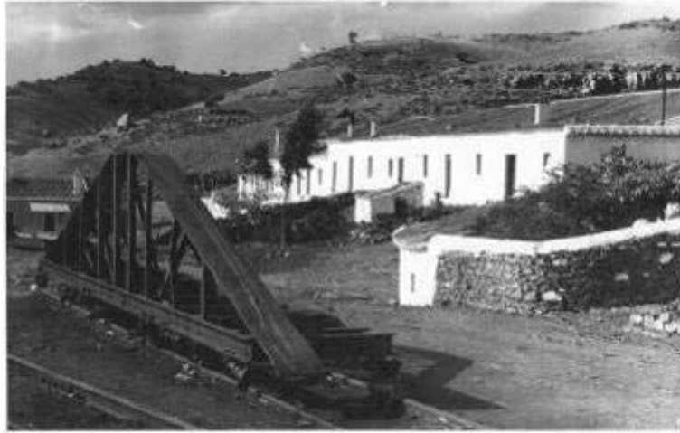
Figura 64. Volcador mecánico de vagonetas en el Puerto de La Laja.
