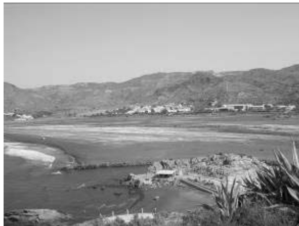
Figura 308. Instalaciones del Lavadero Roberto.
