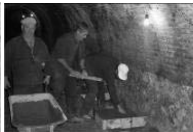
Figura 201. Desarrollo de los trabajos de rehabilitación (Fototeca Fundación Riotinto).
