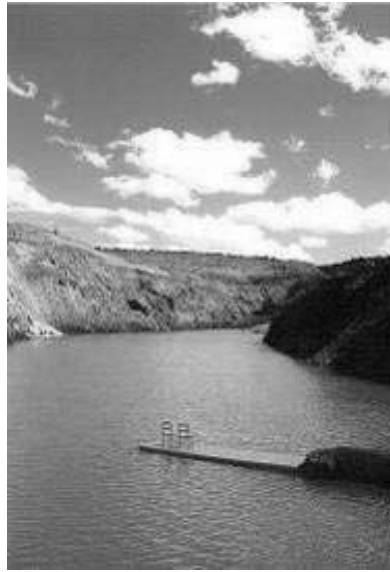
Figura 170. Instalación en la mina Menerillo. Javier Tudela, 2000.
