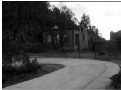
Figura 205. Casa de máquinas en ruinas y malacate desmontado (2005) (Foto: Aquilino Delgado Domínguez).
