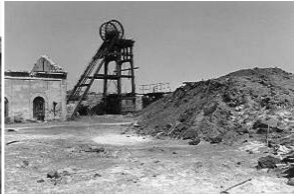
Figura 300. Pozo de Mina en el Cabezo Rajao.
