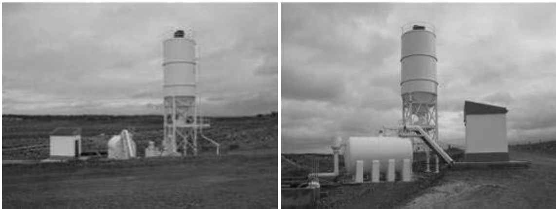
Figura 332. Planta de tratamiento de las aguas ácidas para el riego de naranjos.
