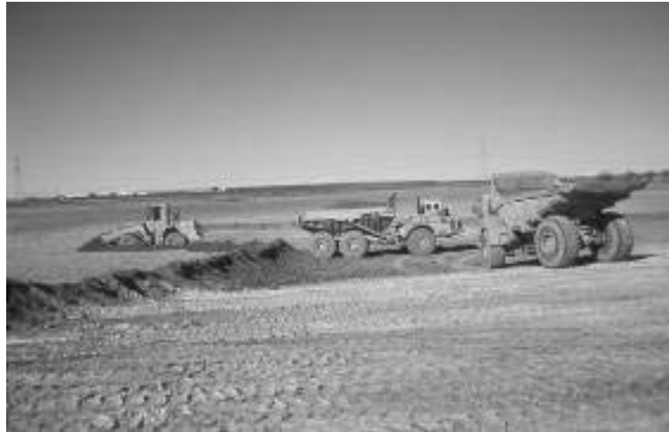
Figura 120. Retirada y acopio de la tierra vegetal original (Foto: TOLSA).
