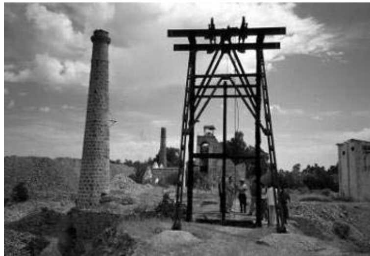
Figura 323. Antiguas estructuras mineras en el distrito plomo argentífero de Linares – La Carolina (Jaén).
