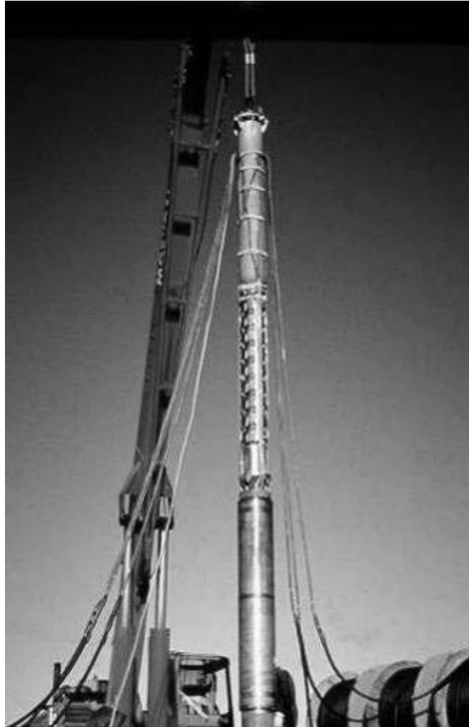
Figura 318. Instalación de bomba en sondeo vertical desde superficie.
