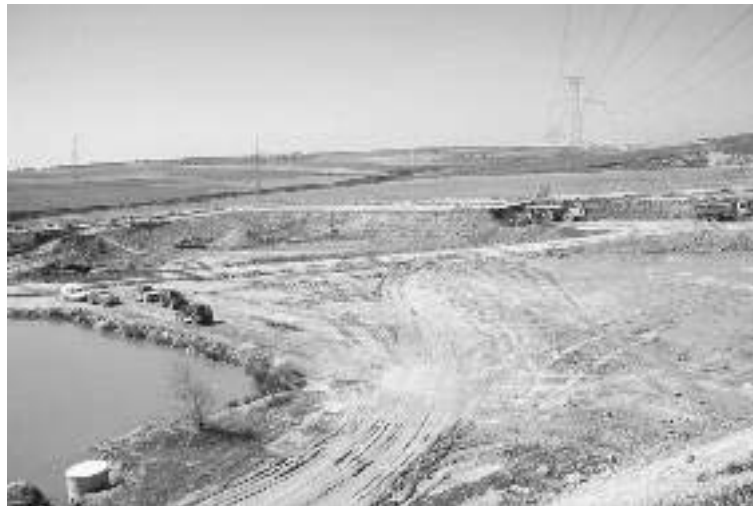
Figura 119. Perfilado de linderos y preparación de rampas a zona de acopio (Foto: TOLSA).
