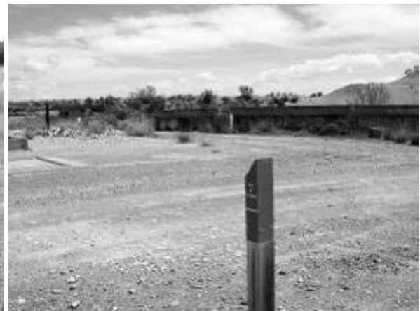
Figura 297. Hito con las instalaciones de la mina detrás. El relieve grisáceo al fondo de la parte derecha de la fotografía, corresponde al material arenoso de una balsa que migra sobre el dique de la misma a modo de duna (Foto: Cynthia Isabel Monescillo).
