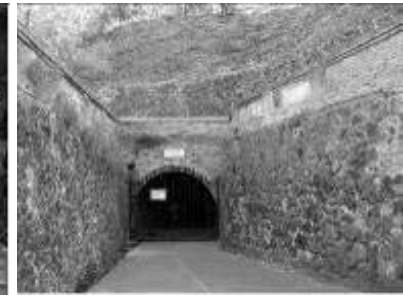
Figura 199. Estado actual de la entrada (Foto Aquilino Delgado Domínguez).
