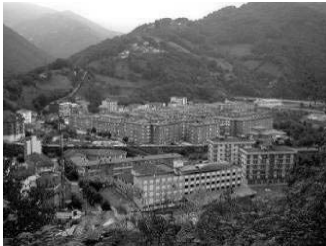
Figura 71. Vista general de la Barriada de El Serrallo en Sotrondio (San Martín del Rey Aurelio, Asturias) (Foto: José Luís Alperi Jove).
