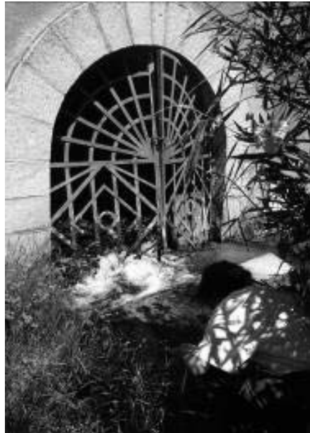
Figura 326. Salida del agua por el socavón de drenaje de Linares, aprovechada por los agricultores para regadío.
