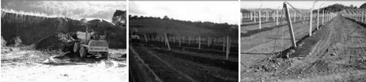
Figura 134. Preparación del terreno (Foto: José Manuel Casas López).
