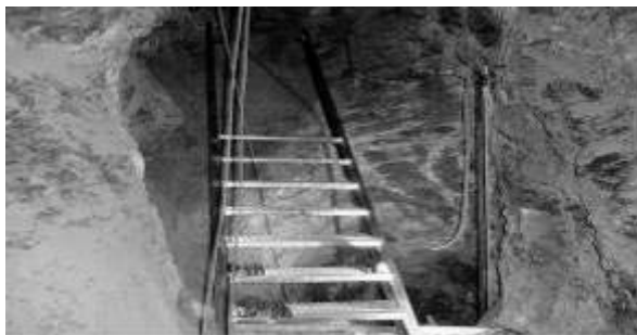
Figura 96. Trabajos de habilitación de salida de emergencia.
