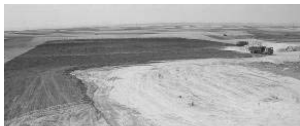
Figura 125. Extendido de tierra vegetal sobre explotación ya rellenada (Foto: TOLSA).
