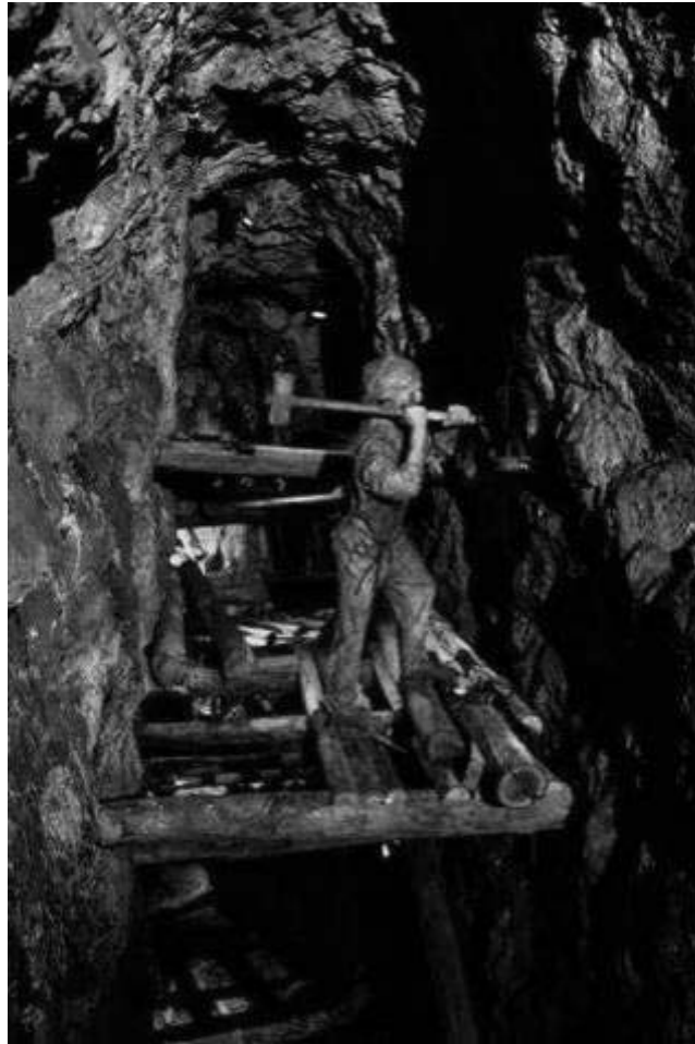
Figura 81. Explotación por testeros en la mina de Almadén (Foto: Domingo).
