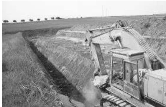
Figura 123. Preparación de cunetas de desagüe, si se requieren. (Foto: TOLSA).
