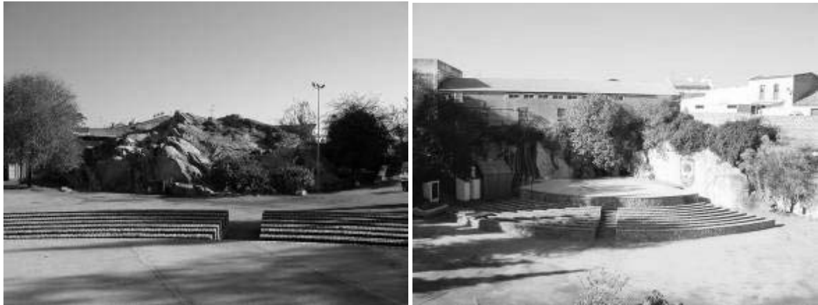
Figura 235. Auditorio de verano La Rodadera en Gerena (Sevilla), construido sobre una antigua cantera de granito (Fotos: Javier Vázquez de Prada y Manuel Ortiz Valderas).
