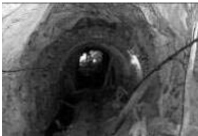
Figura 200. Inicio de los trabajos de rehabilitación del túnel Santa María (Fototeca Fundación Riotinto).
