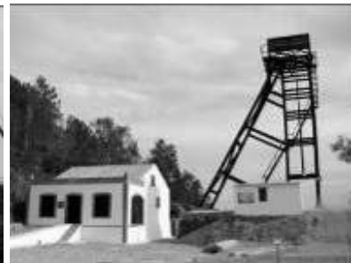
Figura 207. Estado actual tras finalizar los trabajos (2008). (Fotos: Aquilino Delgado Domínguez).
