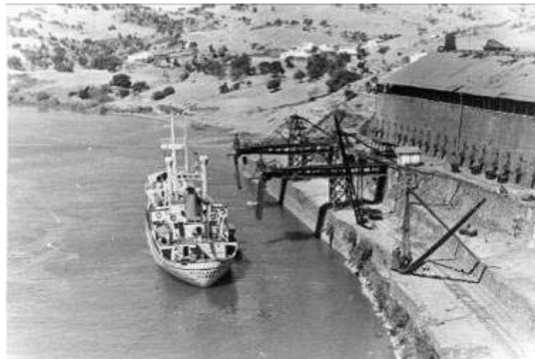
Figura 63. Detalle de las grúas de carga en el muelle de carga del Puerto de La Laja.
