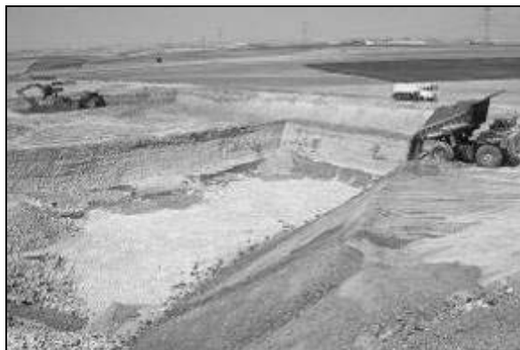
Figura 124. Relleno del hueco paralelo a la extracción de mineral (Foto: TOLSA).
