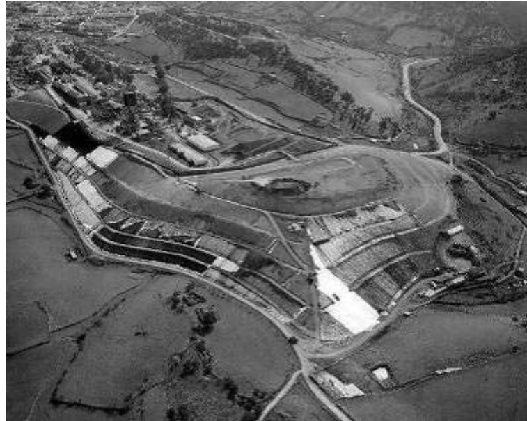
Figura 263. Colocación de geomembranas y geotextiles sobre la escombrera de Almadén (Marzo, 2007) (Foto: Minas de Almadén y Arrayanes, S.A.).
