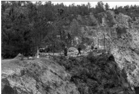
Figura 195. Construcción del muro perimetral de la Corta de Peña de Hierro y de uno de los miradores (Foto: Fototeca Fundación Riotinto).
