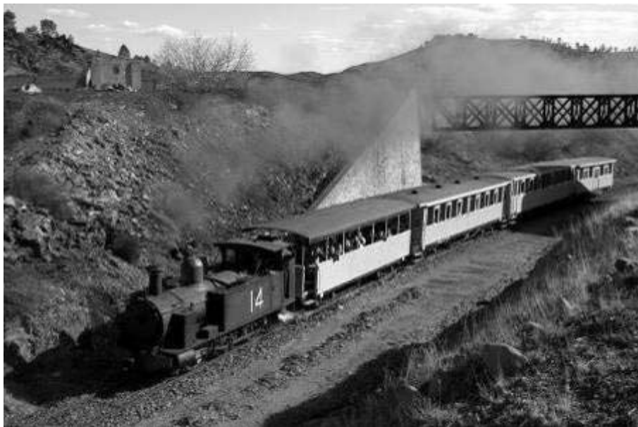
Figura 32. Locomotora de vapor nº 14, fabricada en 1875 (Foto: Manuel Aragón Román).
