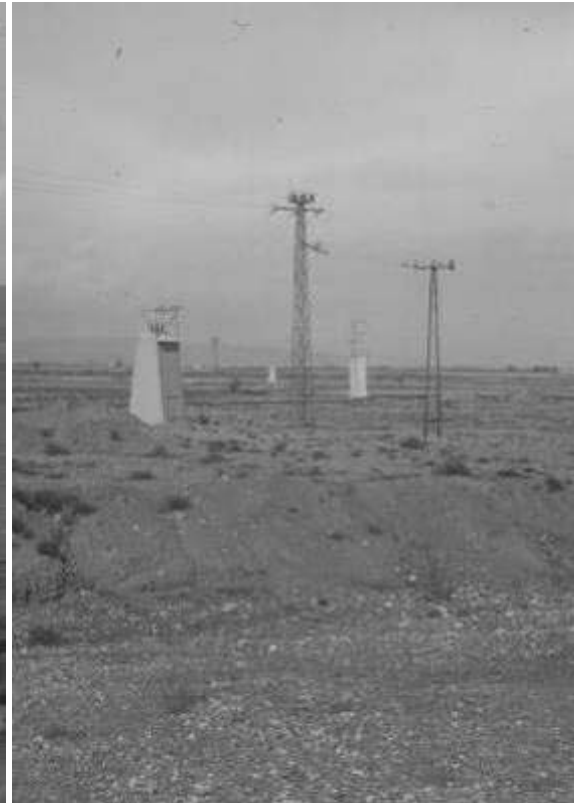
Figura 321. Campo de sondeos de drenaje en la periferia de la mina
