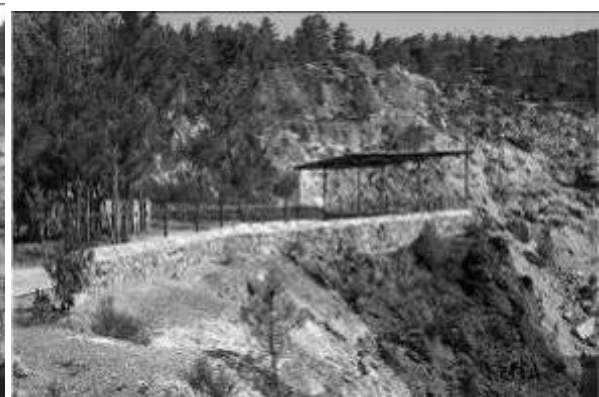
Figura 196. Tramo de muro perimetral y mirador año 2007 (Foto: Aquilino Delgado Domínguez).
