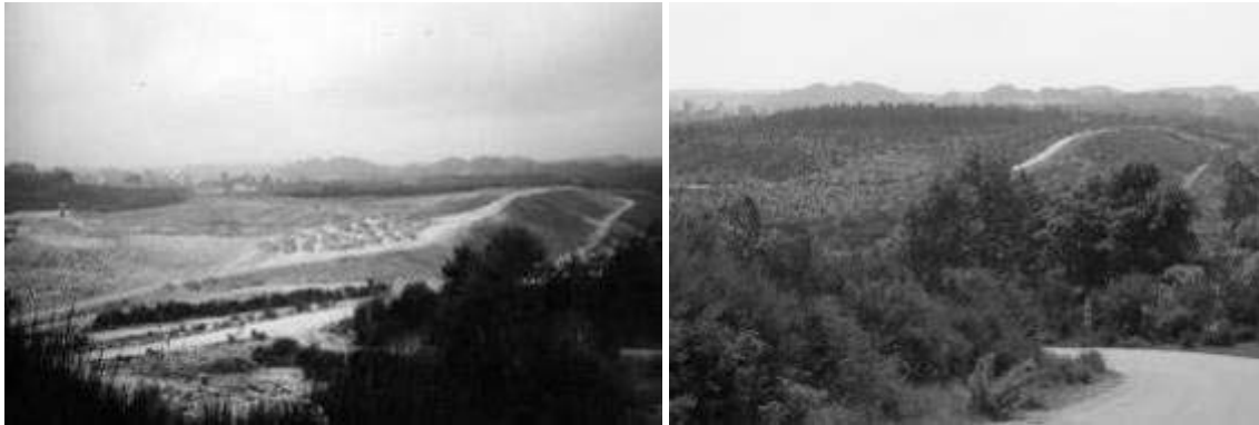
Figura 270. Escombrera de Lignitos de Meirama en fase de construcción y revegetada (Fotos: Juan Luís Delgado Fernández).
