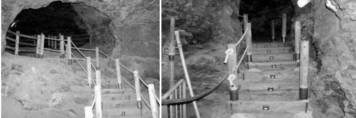
Figura 92. Construcción de escalinatas con traviesas de madera ancladas al terreno, para salvar los desniveles entre las distintas plantas de la explotación.
