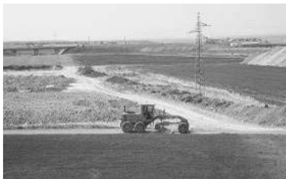
Figura 127. Repaso de baches y construcción de cunetas en los caminos compartidos (Foto: TOLSA).
