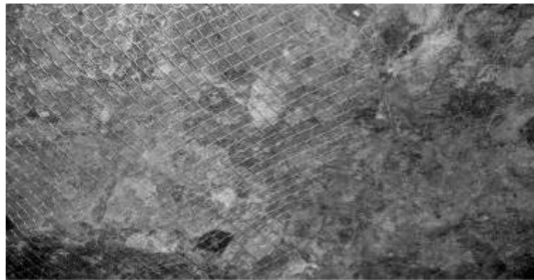
Figura 91. Sostenimiento de techo mediante malla metálica y bulonado.
