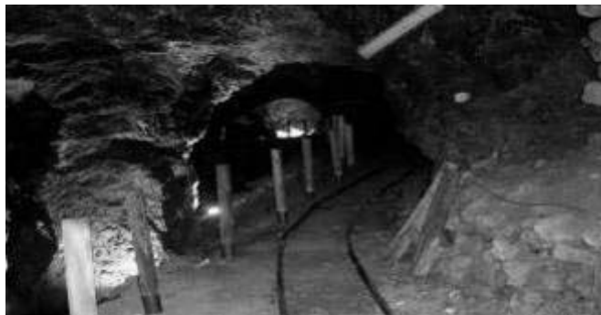
Figura 93. Soportes de pino anclados al terreno para la instalación de barandilla de cuerda.
