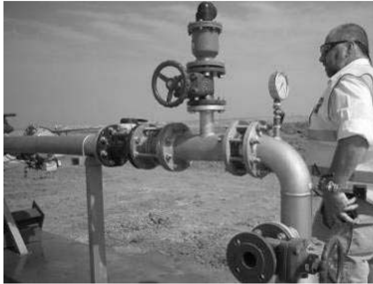
Figura 315. Controles en el sistema de drenaje – reinyección en la mina de Cobre Las Cruces (Sevilla) (Foto: Rafael Fernández Rubio).
