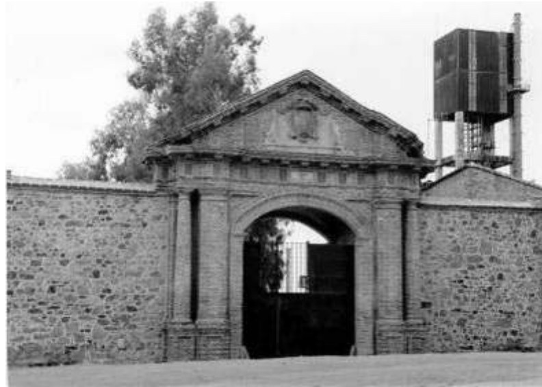
Figura 38. Puerta de Carlos IV y pozo de San Joaquín al fondo (Foto: Domingo).
