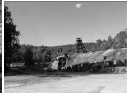
Figura 194. Estado tras las labores de desescombro, limpieza y encauzamiento de las escorrentías (año 2006) (Foto: Aquilino Delgado Domínguez).
