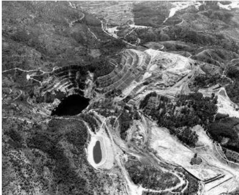
Figura 190. Foto aérea Mina Peña del Hierro (Foto: Fototeca Fundación Riotinto).
