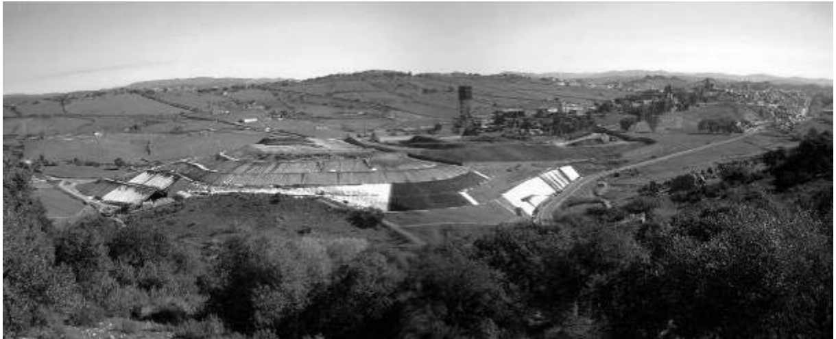
Figura 264. Vista panorámica de la escombrera de Almadén, en plena actividad de colocación de geotextiles y geomembranas (marzo, 2007) (Foto: Minas de Almadén y Arrayanes, S.A.).
