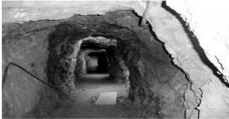
Figura 86. Túnel de acceso a la explotación.
