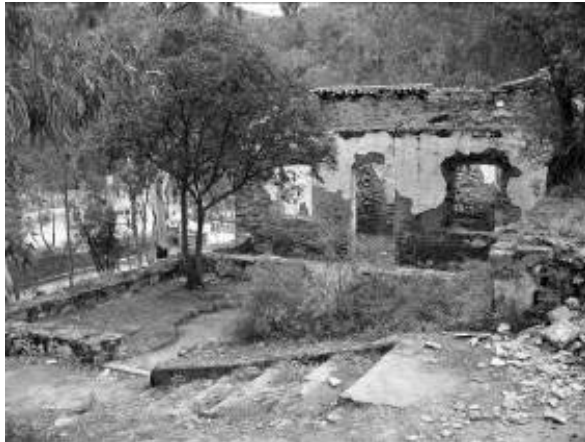
Figura 208. Casa de obreros en estado ruinoso (2007) (Foto: Aquilino Delgado Domínguez).
