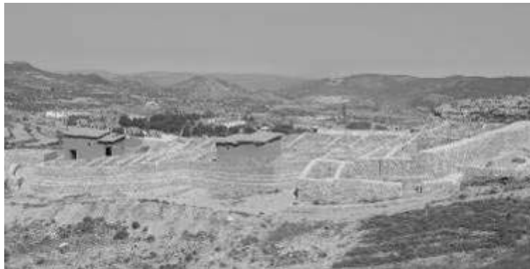
Figura 162. Vista general del poblado reconstruido en la ladera del cerro San Macario (Andorra, Teruel) (Foto: Francisco Molina Cortecero).
