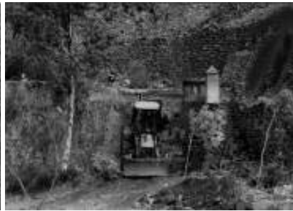
Figura 198. Trabajos de limpieza de la boca del Túnel (Fototeca Fundación Riotinto).
