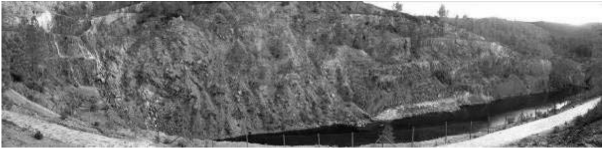
Figura 216. Vista Panorámica NE – NO de la Corta Concepción, donde se aprecia el vallado y el sendero perimetral. (Foto: Aquilino Delgado Domínguez).
