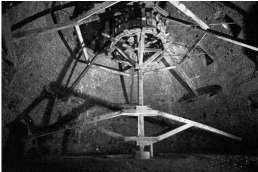
Figura 79. Baritel de San Andrés (mina de Almadén) (Foto: Domingo).
