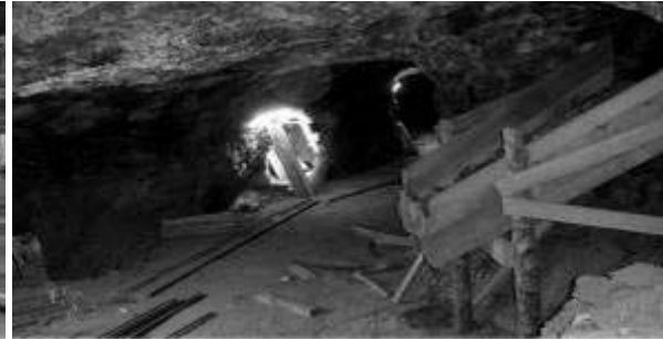
Figura 99. Reconstrucción de las tolvas de descarga del mineral desde un nivel a otro inferior
