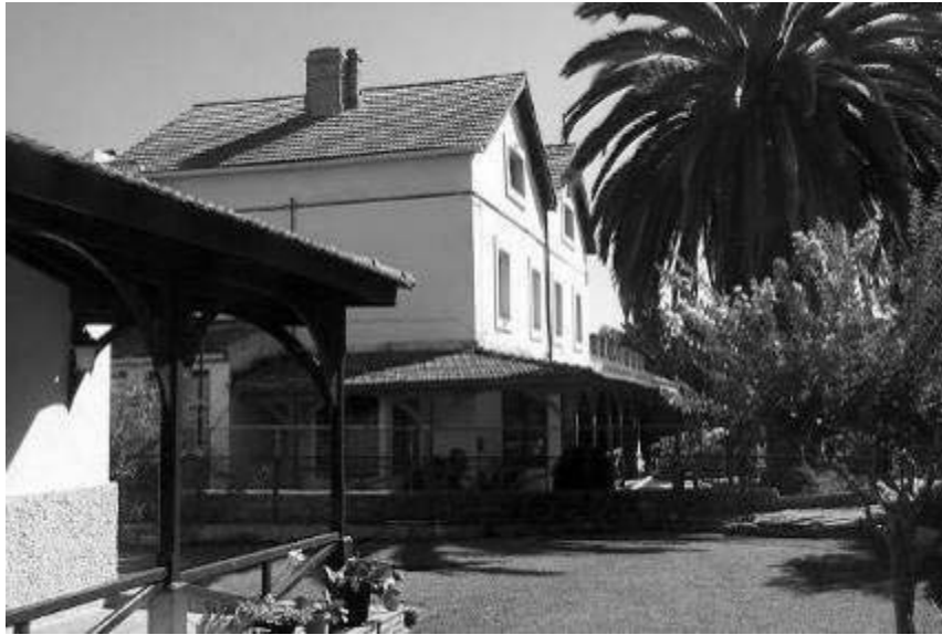
Figura 25. Fachada de la Casa nº 21 del Barrio de Bella Vista Sección Etnográfica del Museo Minero (Foto: Aquilino Delgado Domínguez).
