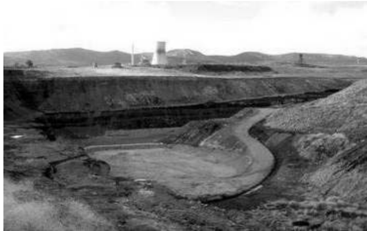
Figura 237. Preparación del hueco final de la mina La Extranjera, por el Ayuntamiento de Puertollano, para Depósito Controlado de Residuos Inertes (Foto cedida por la Concejalía de Medio Ambiente del Ayuntamiento de Puertollano).
