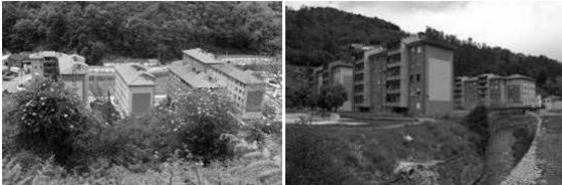
Figura 72. Vista general de la Barriada de Murias (Mieres, Asturias) (Foto: José Luís Alperi Jove).
