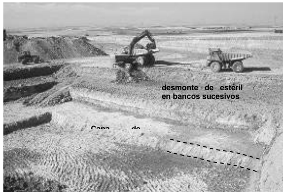
Figura 121. Minería de transferencia. Desmonte de estériles y limpieza de la capa de sepiolita (Foto: TOLSA).
