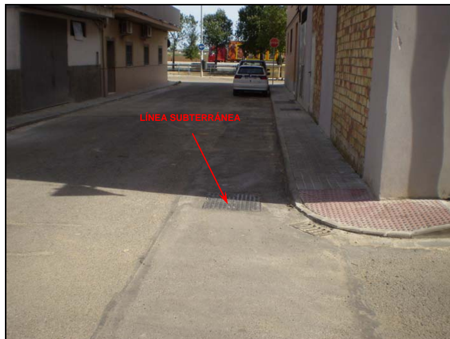
Fotografía nº 5.- Vista de la red enterrada de electricidad existentes en la calle Verdad. La calle que se observa al fondo de la imagen es Indulgencia.
