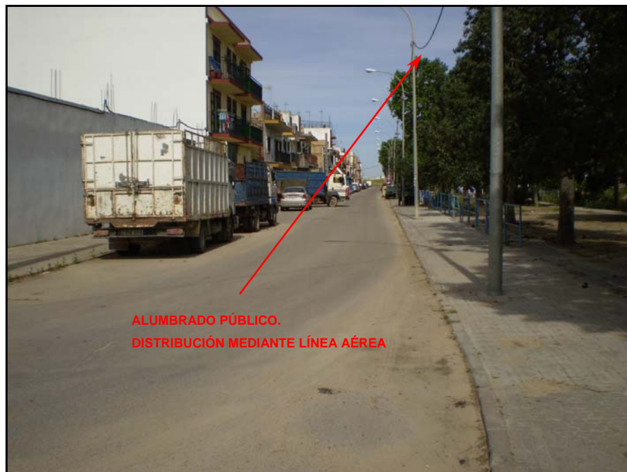
Fotografía nº 2.- Vista general de la calle Indulgencia desde la intersección con la calle Afecto. El alumbrado en la calle es unilateral y la línea distribuye de forma aérea.
