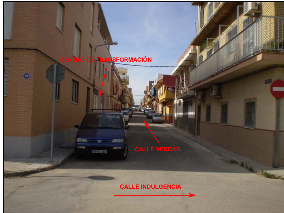
Fotografía nº 4.- Imagen tomada desde la calle Indulgencia hacia la calle Verdad. En el acerado izquierdo de la imagen se localiza el centro de transformación existente.
