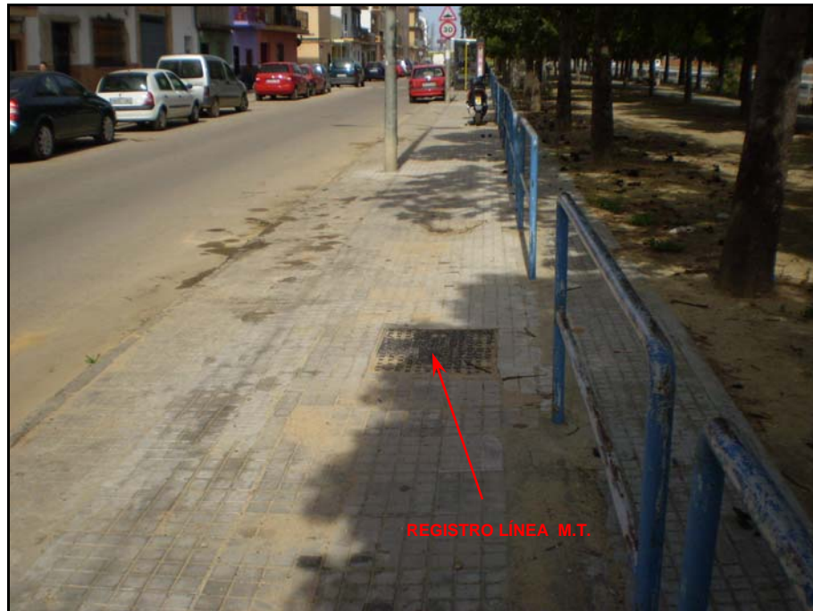
Fotografía nº 11.- Registro de la línea de media tensión enterrada existente en la calle Indulgencia (acerado derecho según sentido de circulación).
