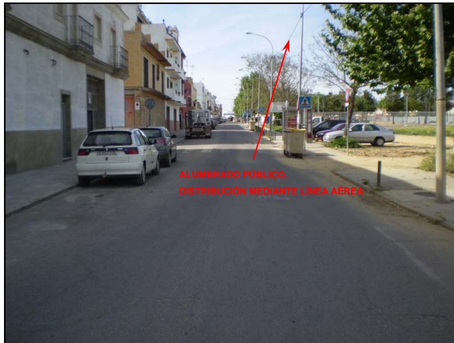
Fotografía nº 13.- Vista general de la calle Honestidad desde la intersección con la calle Indulgencia. La sección de la calle está compuesta por acerado, aparcamiento en cordón sin delimitar, vial de un único sentido y acerado. Tan solo existen viviendas en un acerado (izquierdo según sentido de circulación) y el alumbrado público, con distribución aérea, se localiza en el lateral del acerado sin viviendas.
