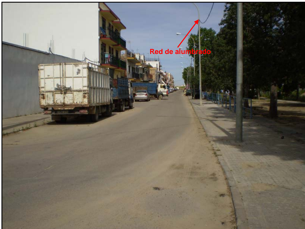
Fotografía 1.- Vista general del alumbrado público existente en la calle Indulgencia.
