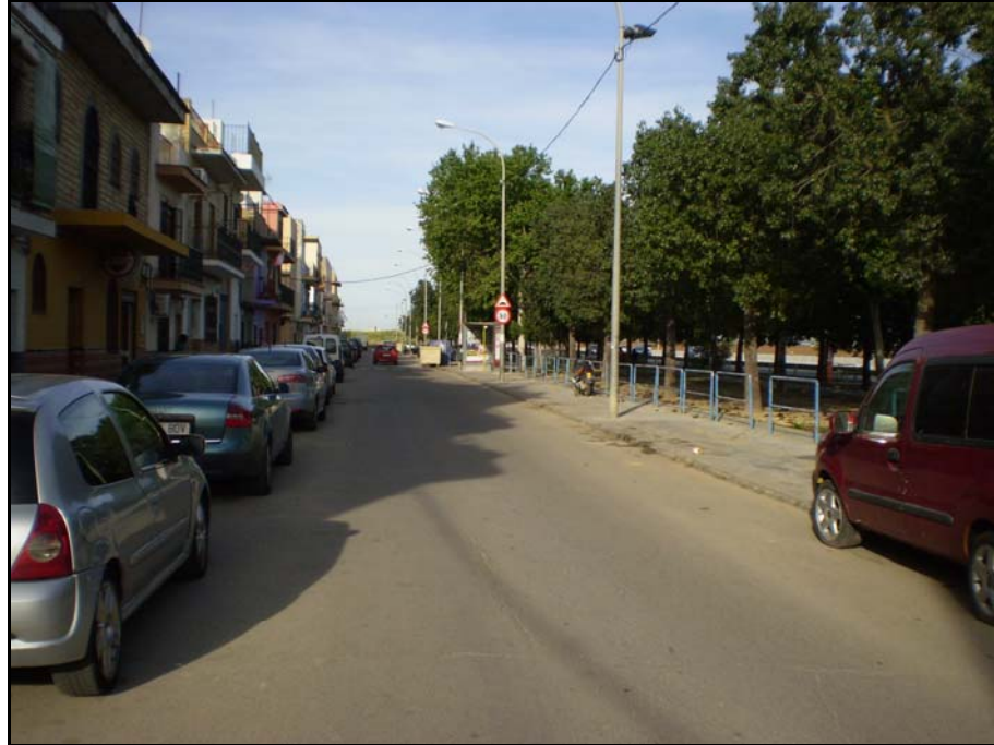
Fotografía nº 1.- Vista general de la calle Indulgencia desde la intersección con la calle Juventud. La sección actual de la calle, de izquierda a derecha, está formada por acerado, aparcamiento en cordón sin delimitar, vial de un único sentido, acerado y zona ajardinada colindante con la SE-021.
