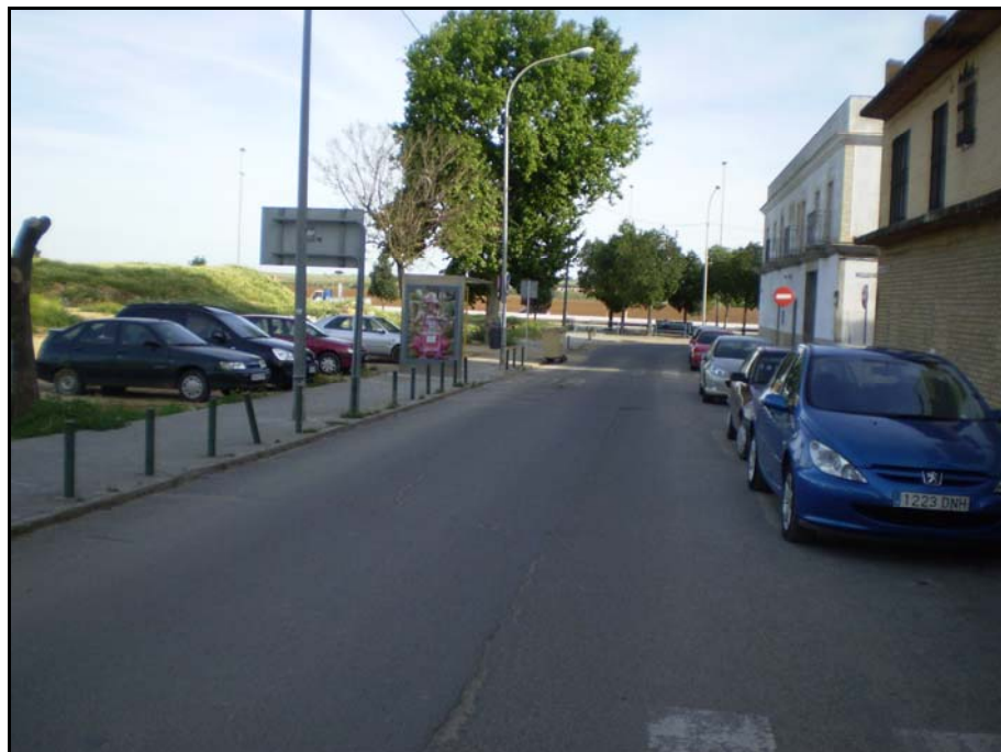
Fotografía nº 14.- Vista de la calle Honestidad. En esta calle no se localiza ninguna red de telefonía ni electricidad. Las acometidas de estos servicios a las viviendas de esta calle se realizan desde las calles perpendiculares.
