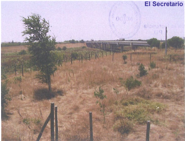
Paso variante Bellavista sobre el cauce del Guadaira
