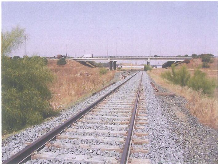
Paso inferior sur al vial de servicio del Guadaira
