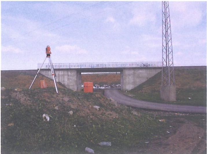
Accesos a la estación de bombeo de Emasesa
