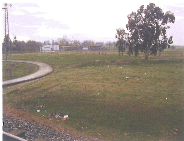
Plataforma del ferrocarril del Puerto, junto a la estación de bombeo
