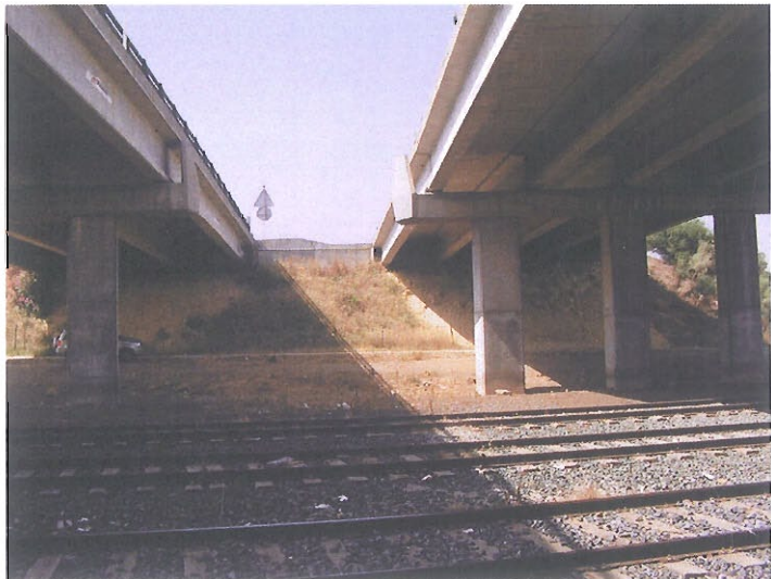
Paso superior de la variante de Bellavista y plataforma del ferrocarril
