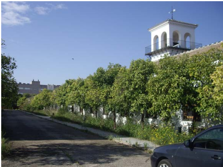
Foto 2 : Nave a conservar para equipamiento. Alzado Este.
