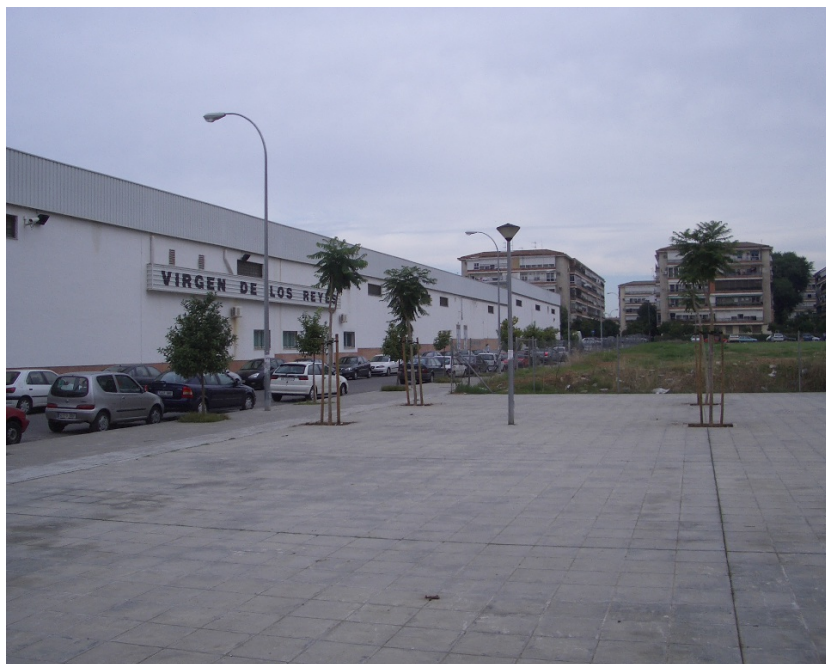
Foto 3 : Estado actual Nave Vodafone. Alzado a calle Chaparro.
