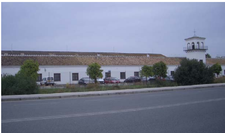
Foto 1 : Fotografía de una de las naves a mantener para equipamiento. Alzado Oeste.
