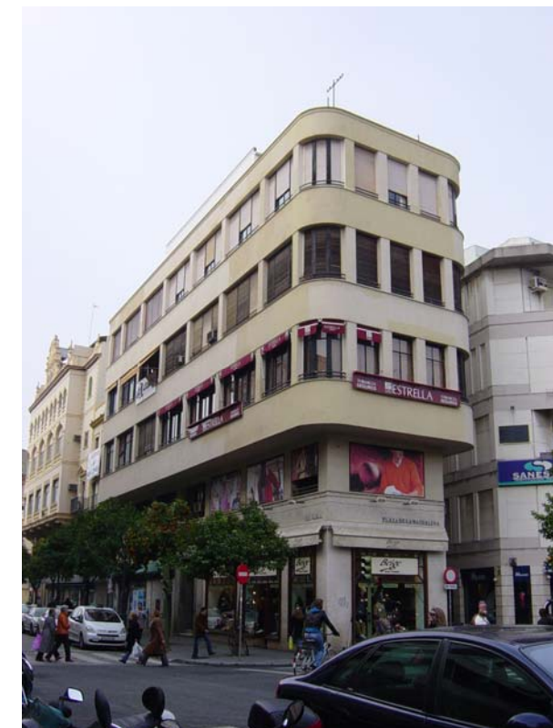
Edificio Cabo Persianas
