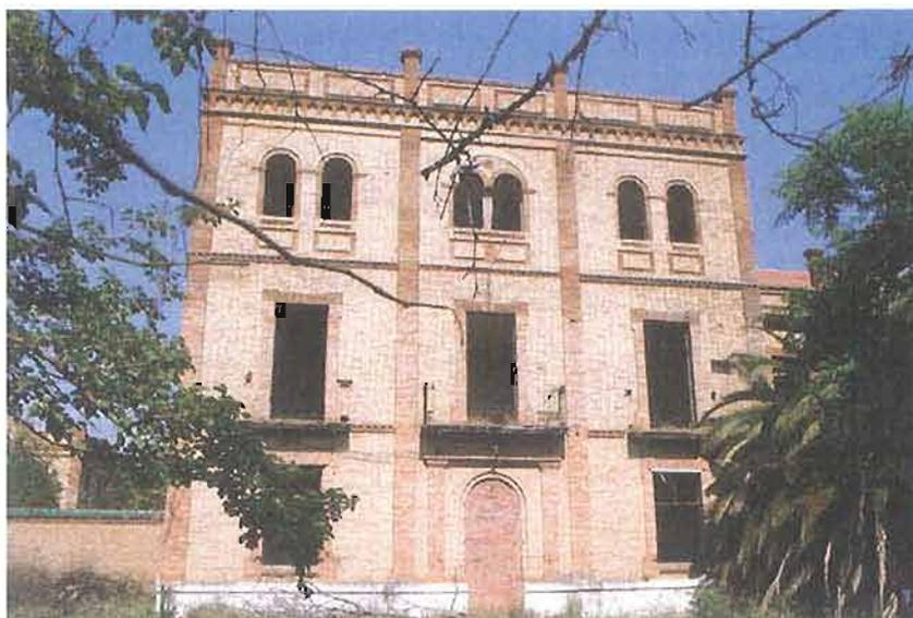
Los edificios se resuelven combinado los materiales descritos. La mayoría de los edificios son de ladrillo visto, con muros de carga de ladrillo, eventualmente pilares de hormigón. En construcciones abiertas no habitables la estructura es de pilares metálicos. Forjados y vigas de hormigón armado en estructuras principales, combinando forjados de vigueta metálica y rasilla en elementos secundarios. Bóvedas cerámicas en escaleras de edificios principales. Cubiertas planas con cámara
