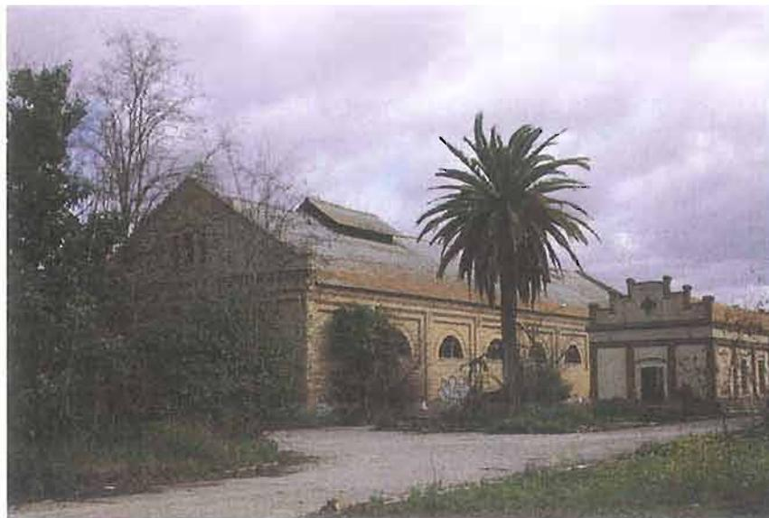
En la esquina noreste, la gran nave (6) de 50x16,5 m, con cubierta a dos aguas y sobre el eje de la batería del lado izquierdo, ofrece el mayor espacio cubierto en tamaño y altura libre del cuartel. Totalmente diáfano con la estructura de cerchas vista era utilizado como gimnasio. Al disponer de tribuna sobre la entrada en el lado este y otra salida en el lado opuesto era utilizado también como salón de actos.
