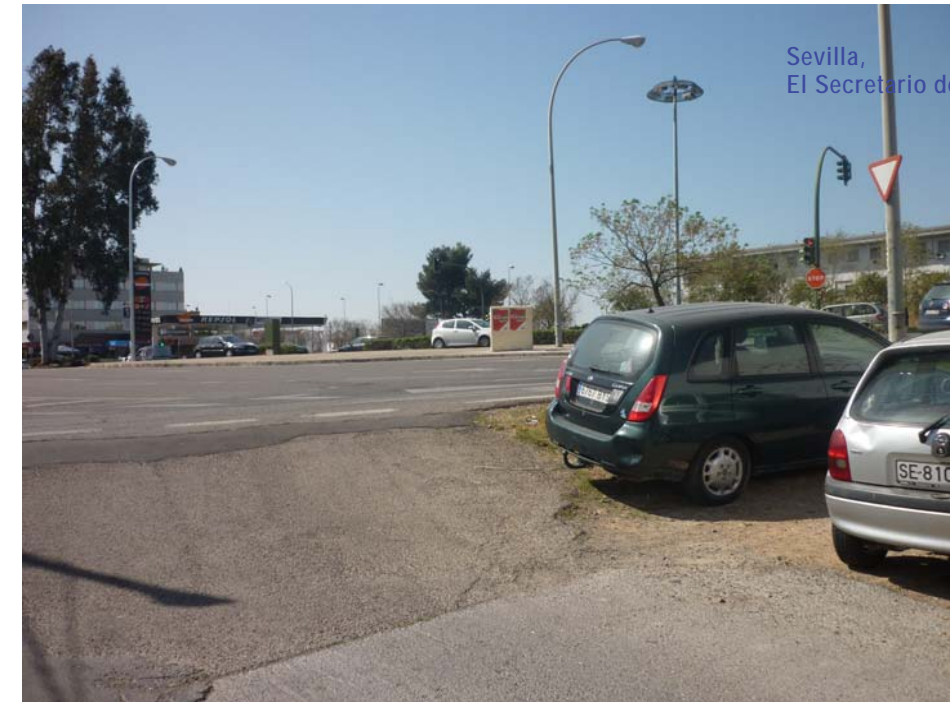
Conexión en terraplén con avenida de Jerez (27/03/2012)
