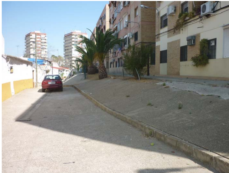
Estado actual de la calle y de su viario. (27/03/2012)
