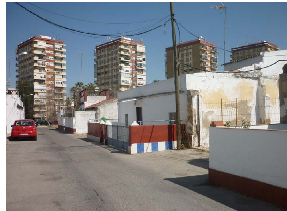
Solares de edificaciones demolidas (27/03/2012)
