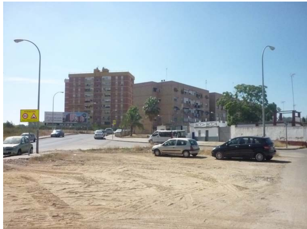
Estado de las obras del SGEL-22 PARQUE GUADAIRA. CAUCE ANTIGUO y viviendas existentes de la barriada(20/06/2012)
