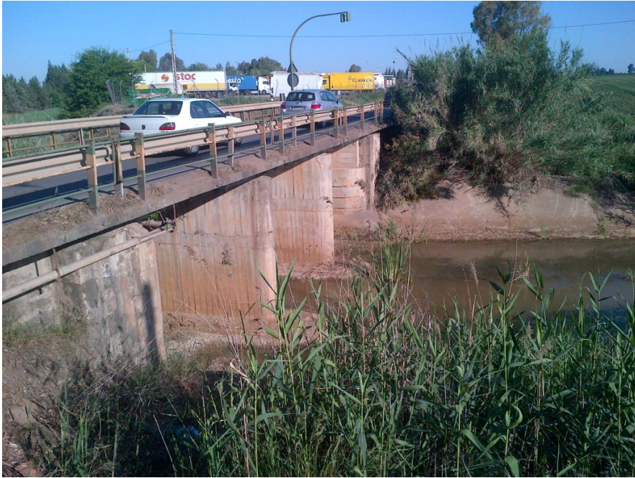
Fotografía 1: Obra de paso
