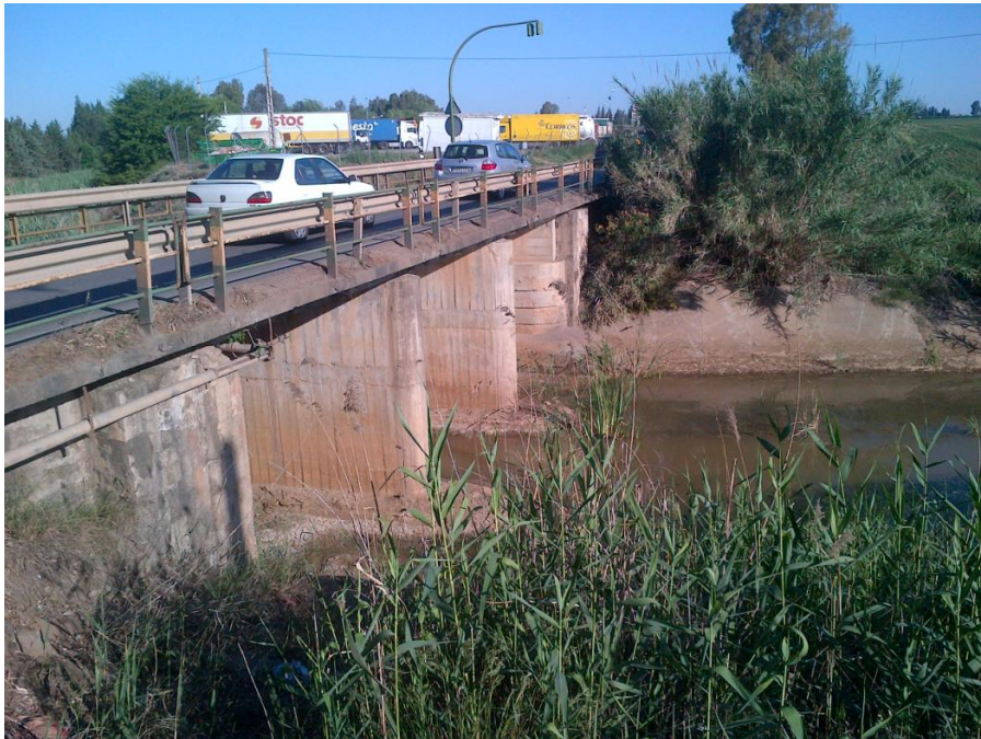
Fotografía 1: Obra de paso
