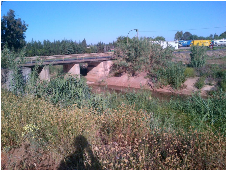
Fotografía 2: Obra de paso
