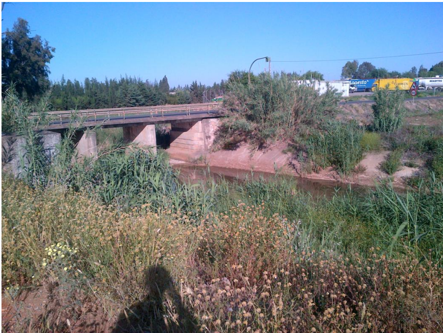
Fotografía 2: Obra de paso
