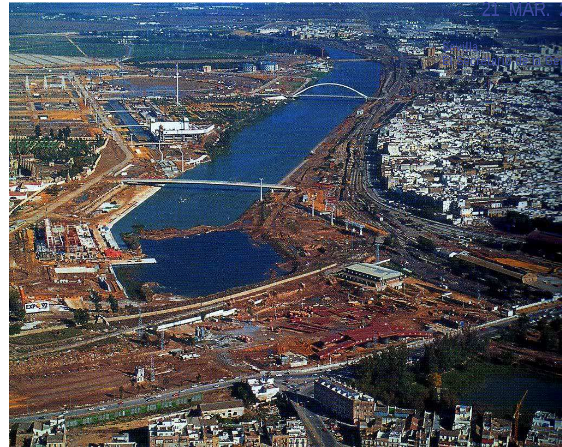
FOTOGRAFÍA DE LA ZONA DURANTE LAS OBRAS PARA LA EXPOSICIÓN UNIVERSAL DE 1992.
