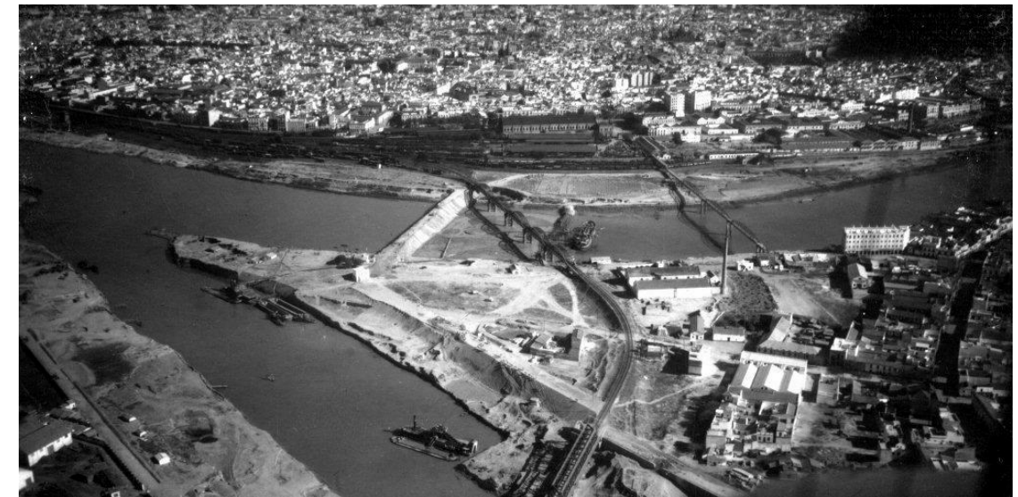
FOTOGRAFÍA DURANTE LAS OBRAS DEL ATERRAMIENTO DE CHAPINA.
