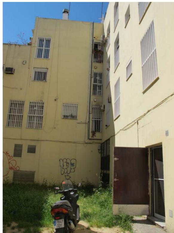
Redes de distribución por fachada de instalaciones eléctricas y de telecomunicaciones. Chimeneas de ventilación.
