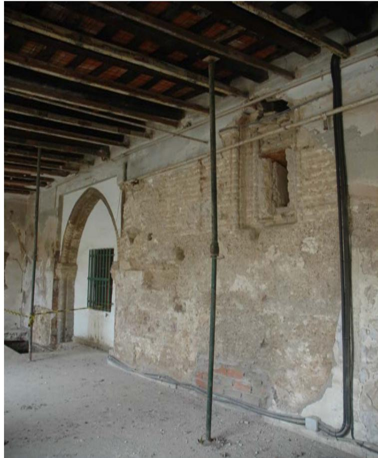
Vista general del acceso al refectorio y ventana mudéjar tras el sondeo paramental. Se advierten forjado antiguo de madera correspondientes a la construcción de la primera planta de la galería en s. XVI; tirantes de hierro para refuerzo estructural tras el terremoto de 1755 y vigas de madera para sostener falso techo en s. XX.
