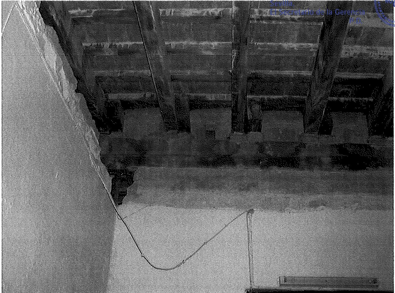
Fotografía 4. Vista del segundo pilar en planta segunda, de iguales características al definido en la anterior fotografía, así como la viga madre de madera que forma el pórtico que soporta la primera y segunda crujía paralela a la fachada a la calle Marqués de Paradas.
