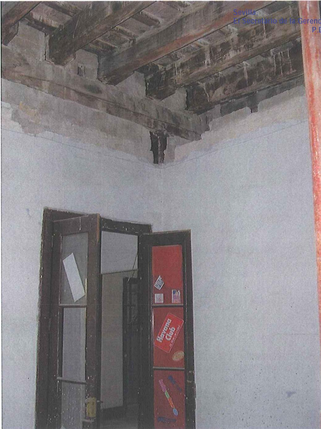
Fotografía 5. Vista del segundo pilar de iguales características al definido en la anterior fotografía, así como la viga madre de madera que forma el pórtico que soporta la primera y segunda crujía paralela a la fachada a la calle Marqués de Paradas
