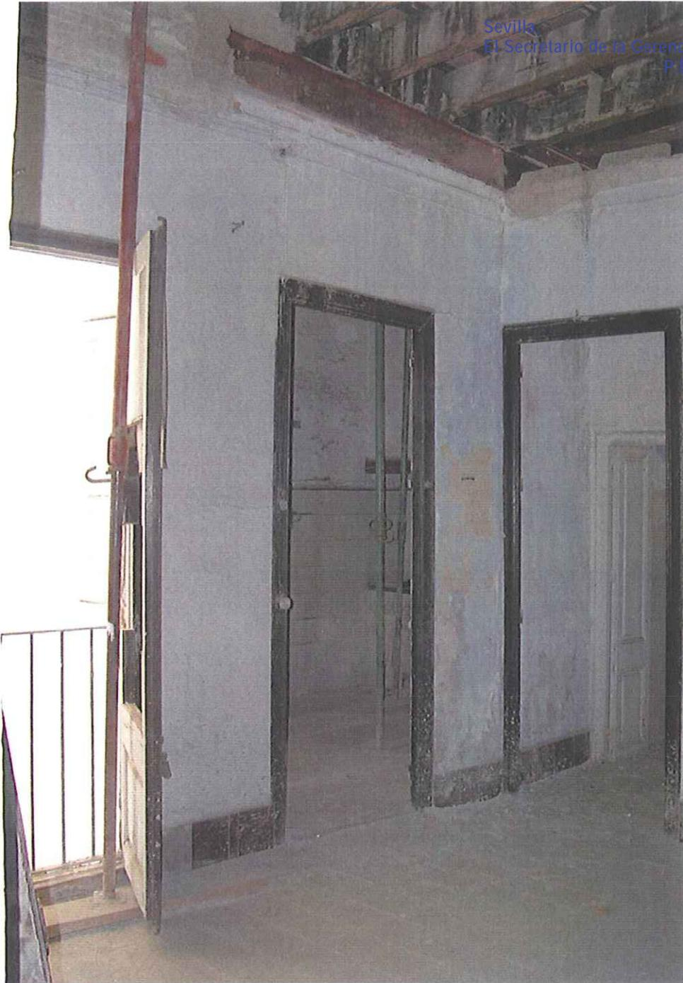
Fotografía 6. Corresponde a una vista desde el estar central de la planta segunda, vemos el hueco abierto al patio y la crujía junto a la medianera con el edificio sito en c/ Luis de Vargas 4, formada por una viga metálica apoyada en una pilastra de fábrica de ladrillo y en el muro medianero.
