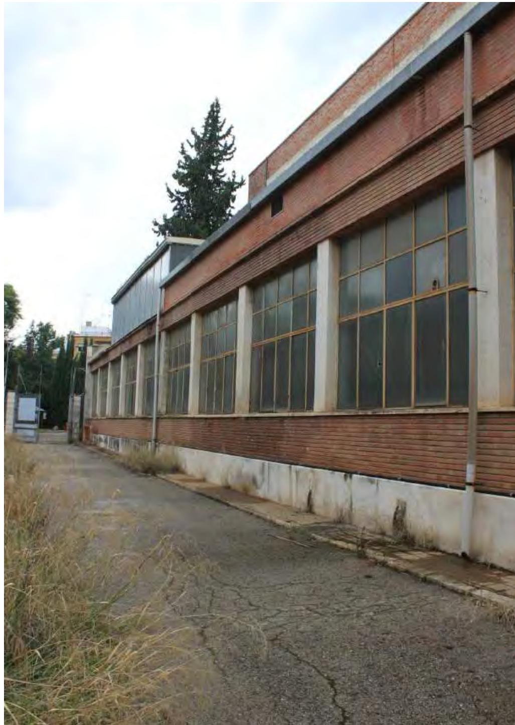
Vista de la ampliación del edificio principal por su fachada Sur.
