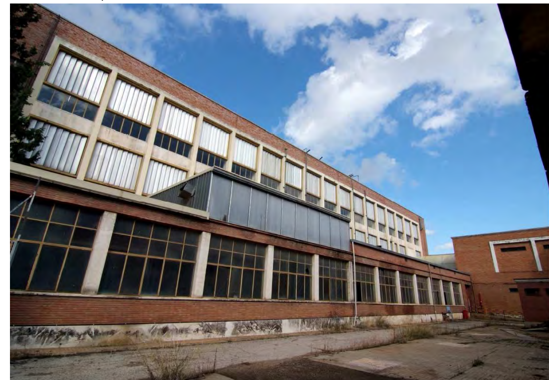
Vista de la ampliación del edificio principal en planta baja
