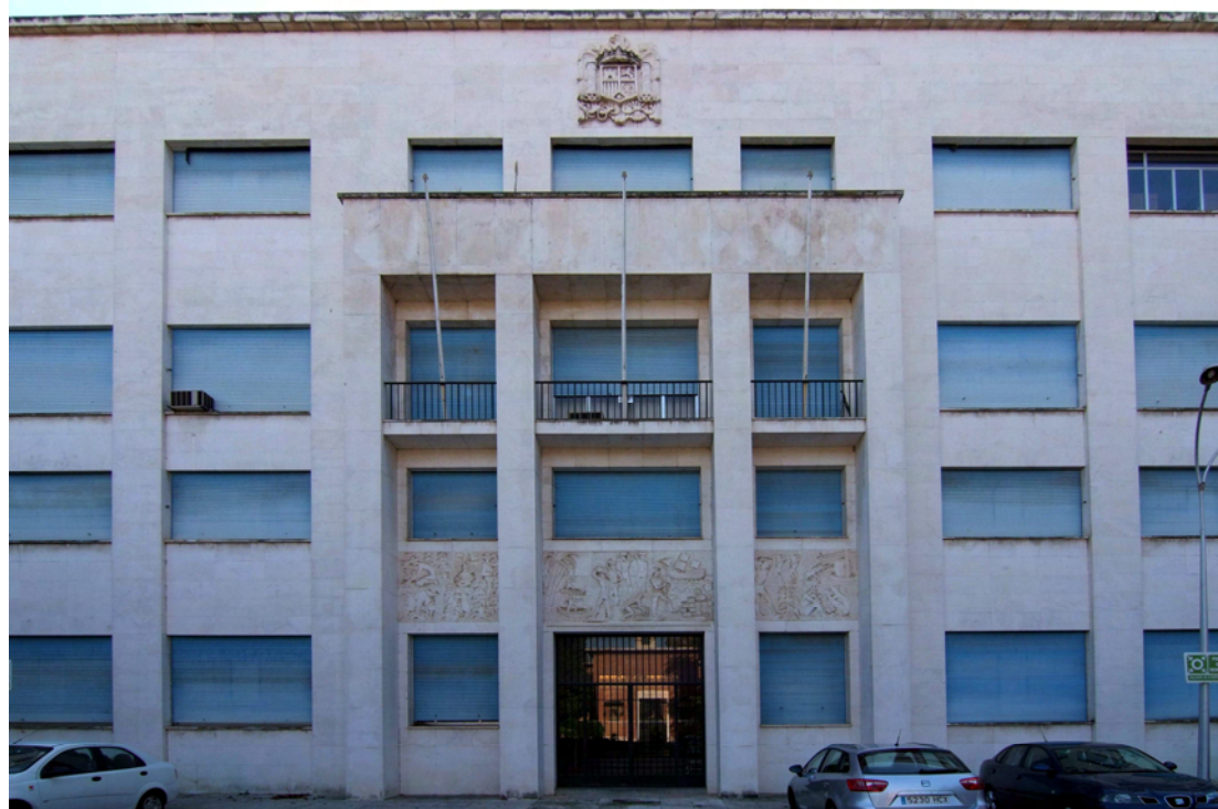
Fachada principal del edificio de Oficinas
