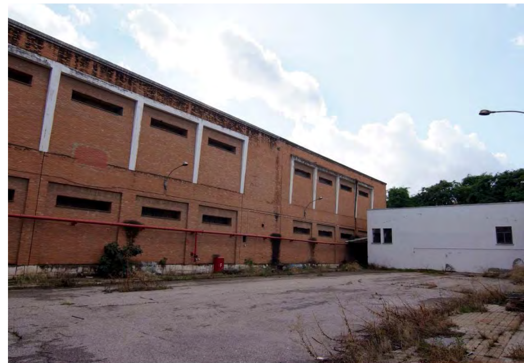
Almacén de Rama 2 y Nave para las instalaciones de protección contra incendios
