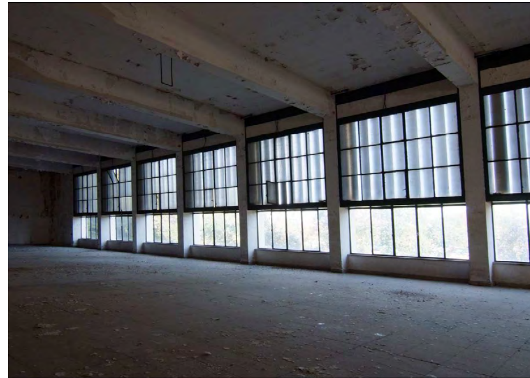
Interior Nave de Talleres
