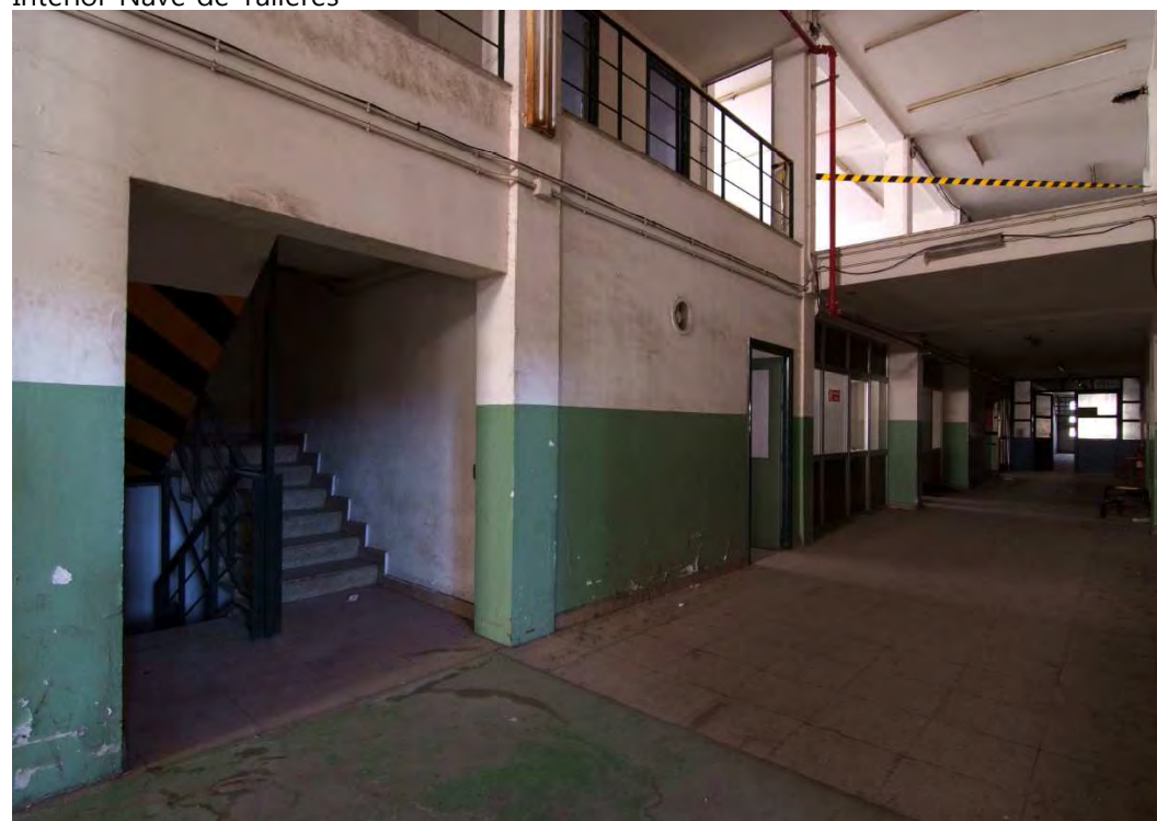
Zona de circulación en edificio de Talleres.
