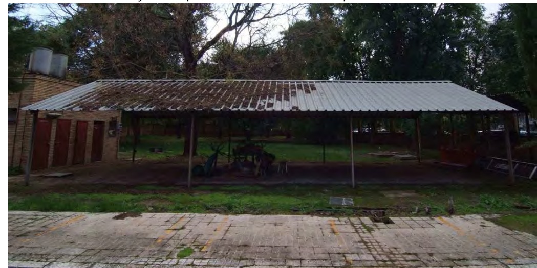
Construcciones ligeras en la zona de jardines
