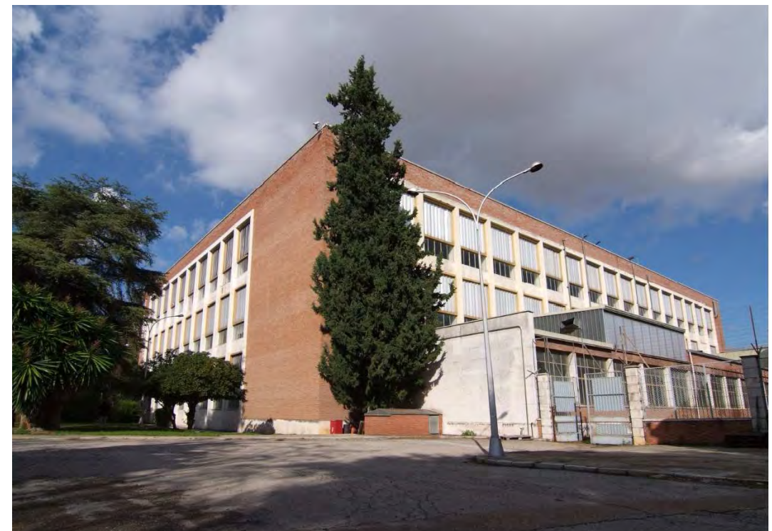
Vista exterior del edificio principal
