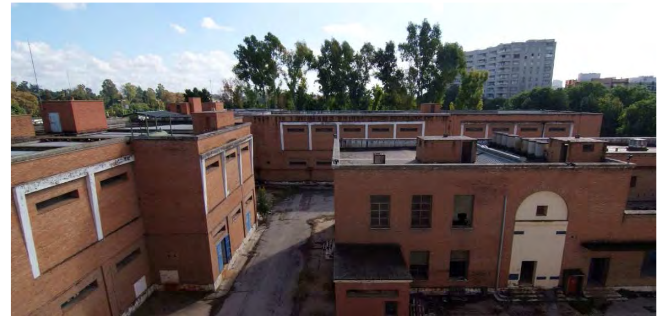
Vista de los Almacenes de Rama y del edificio auxiliar desde la cubierta del edificio de Talleres.
