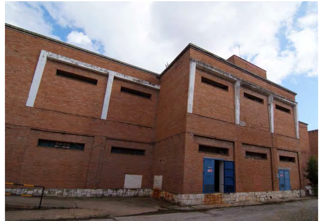
Fachada Oeste del Almacén de Rama 1
