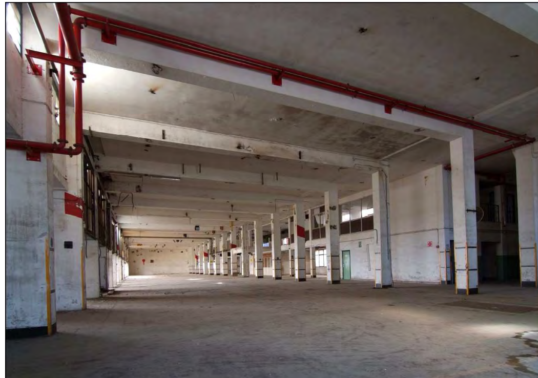
Interior Nave de Talleres
