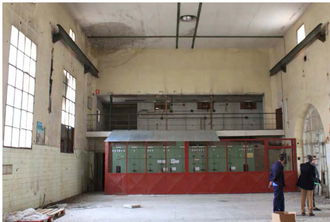
Interior edificio Auxiliar
