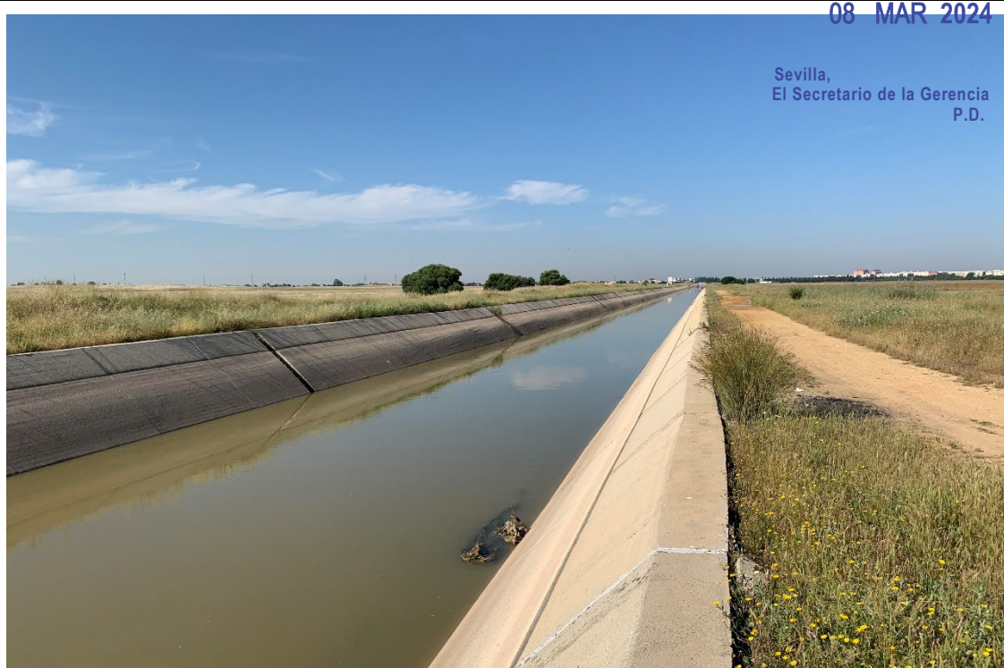
Detalle del acueducto con el que limita el ámbito de estudio en el SUR.
