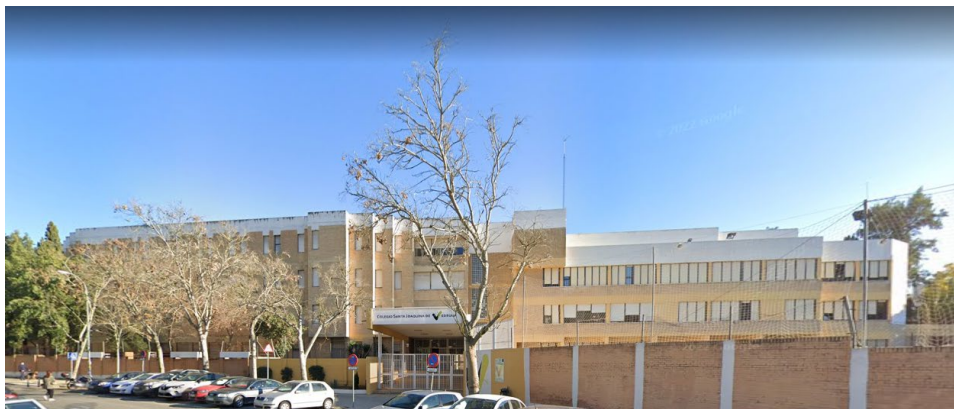
Vista desde la calle Sta Joaquina de Vedruna, desde el Edificio Sevilla 2.
