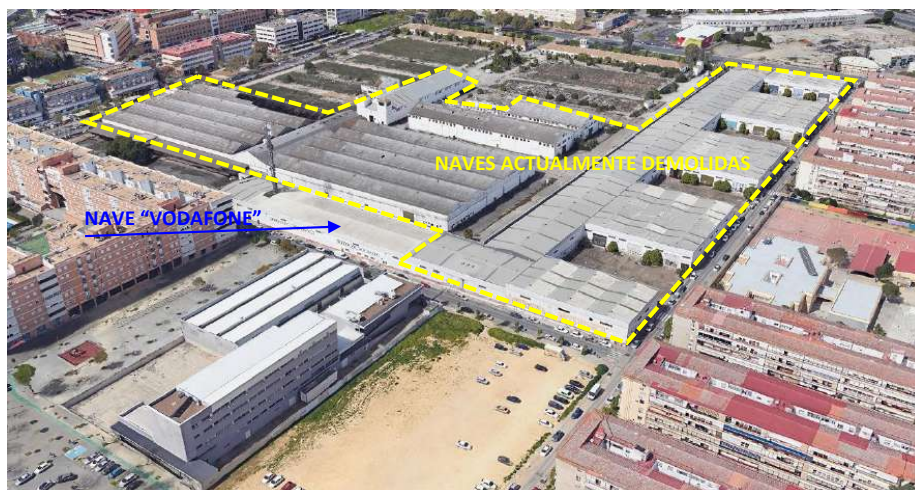
Vista del estado actual desde el este.
